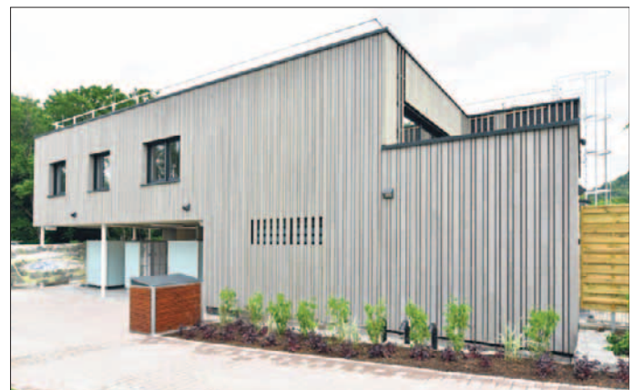
Das neue Technikgebäude mit Mitarbeiterwohnung, Umkleide- und Sanitärräumen sowie einem weiteren Zugang zum Freibadgelände, der bei großem Andrang geöffnet wird.
